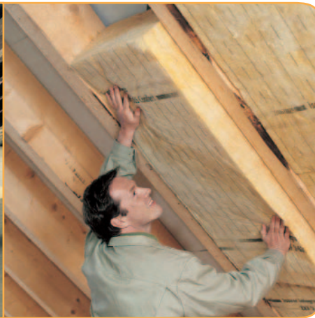
Zwischensparrendämmung
