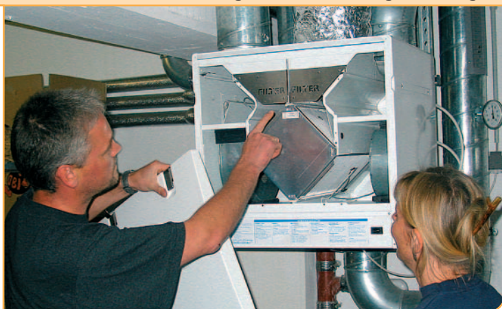
Zentrale Lüftung mit Wärmerückgewinnung
